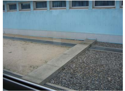
Grenzmarkierung zwischen den Baracken
